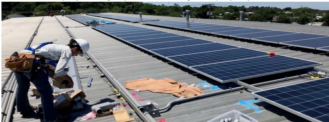
Slika 1: Izvođenje fotonaponskog sistema na krovu poslovnog objekta (izvor: www.carolinasolarquote.com )
